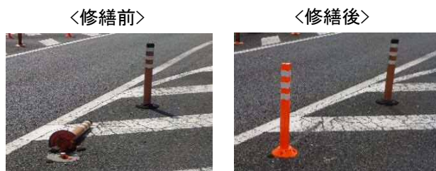
道路緊急修繕
