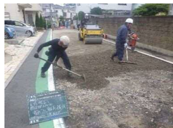
土木緊急修繕
