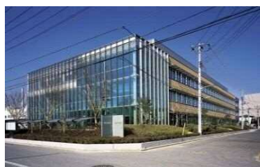
緑区役所庁舎
