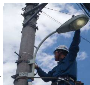
道路照明灯の修繕の様子
