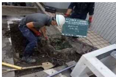
土木緊急修繕の様子
