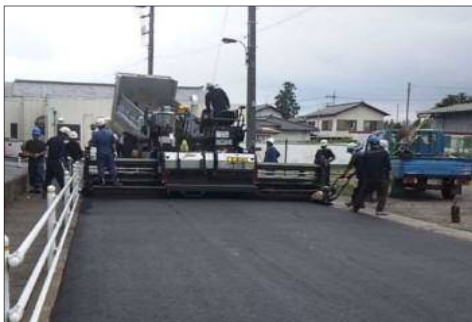
道路等の緊急修繕
