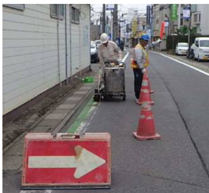
路面表示修繕
