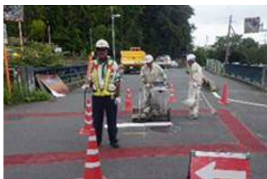
路面表示修繕
