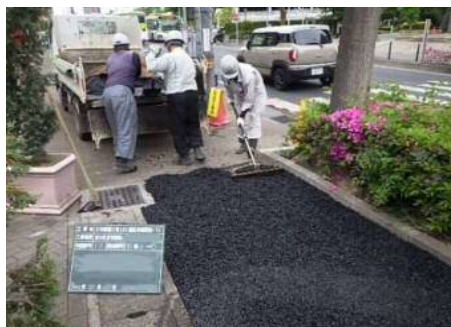
【道路緊急修繕】
