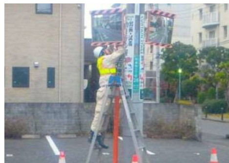
【交通安全施設修繕】
